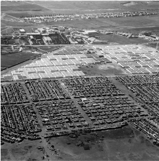
Carrières Centrales Parke Sud
