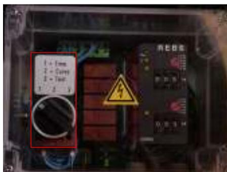
Fig. 21 Sistema de controlo do lubrificador de verdugo
